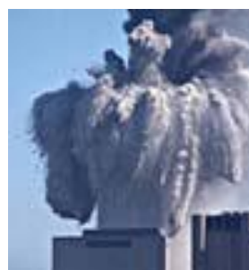
Fig.2 : Destruction de la Tour Nord – Vue latérale
